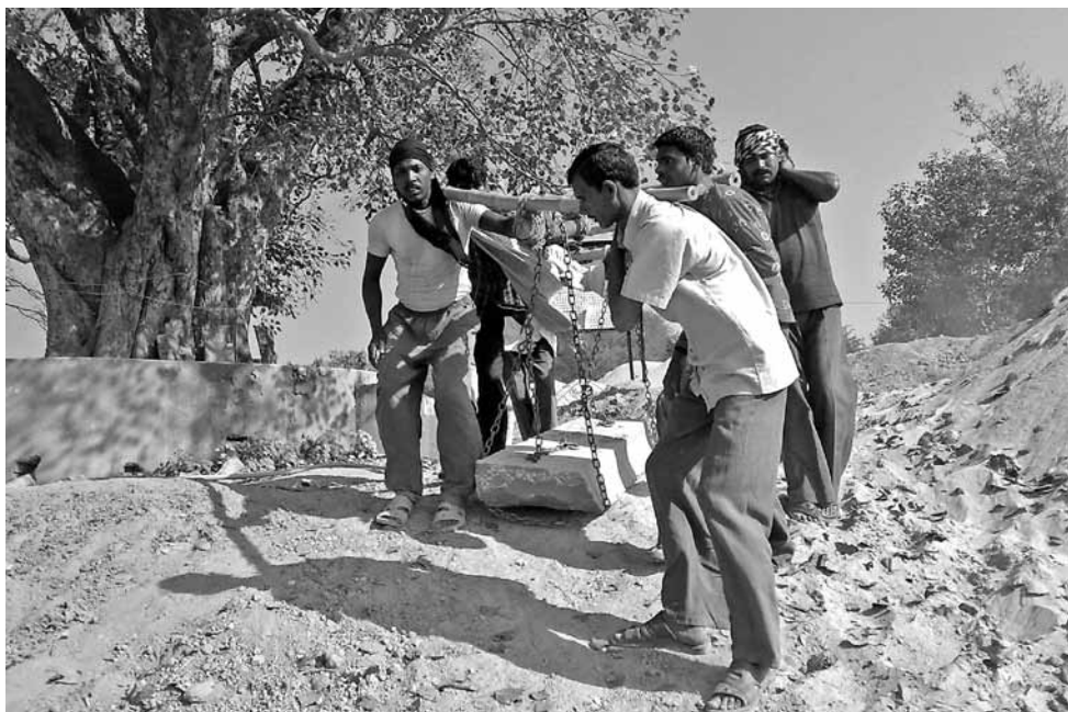
Die Arbeiten für die neue Ganges-Ufergestaltung (ein Ghat) in KIRAN-Nähe kommen auch ohne Kran zügig voran.
