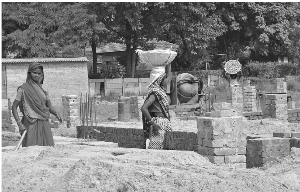
Der Bau des künftigen Ausbildungszentrums (Human Resource Trainings Unit) ist in vollem Gange.
